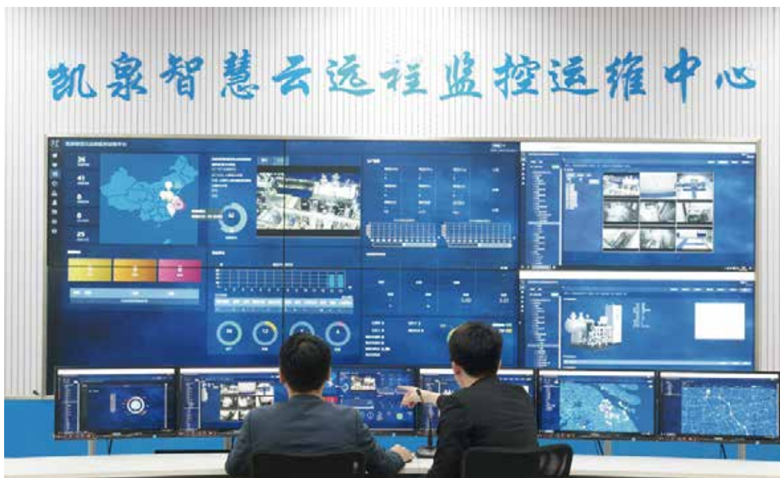
凯泉智慧云远程监控运维中心
