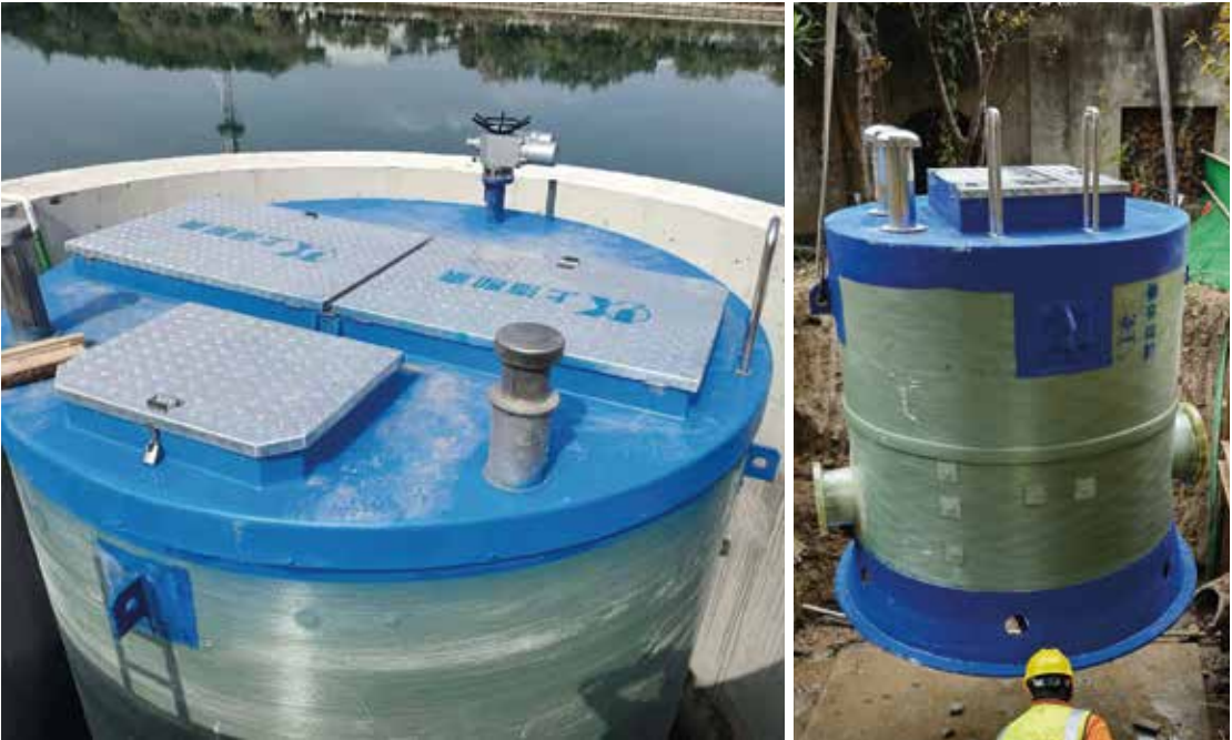
广东某地截污改造项目 泵站规格：DN3800*7300
